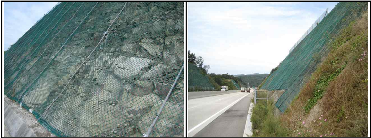
【그림 30.3.4】 보호/보강시설 전경
