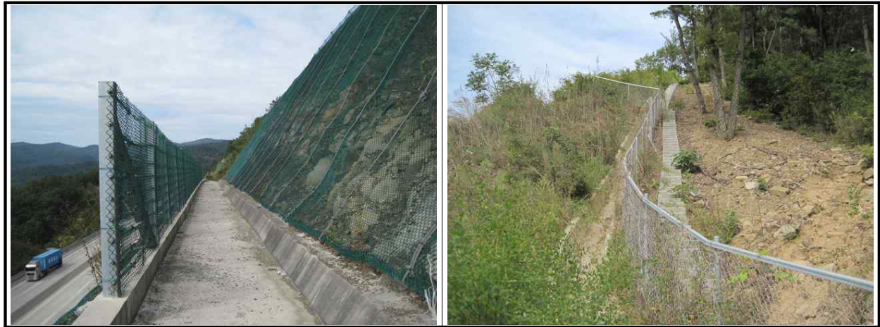
【그림 30.3.3】 배수시설 전경
